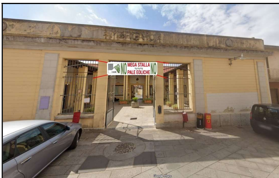
Figura 4: 1) Mercato Civico di via Vittorio Emanuele III. L = 5,0 mt – h = 4,0 mt (Ancoraggio grate esistenti)
