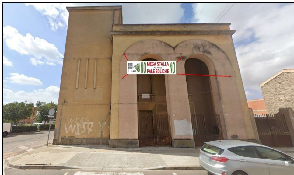
Figura 3: 1) Edificio Ex GIL – lato via Oristano. L = 10,0 mt – h = 5,0 mt (Ancoraggio su ganci esistenti)
